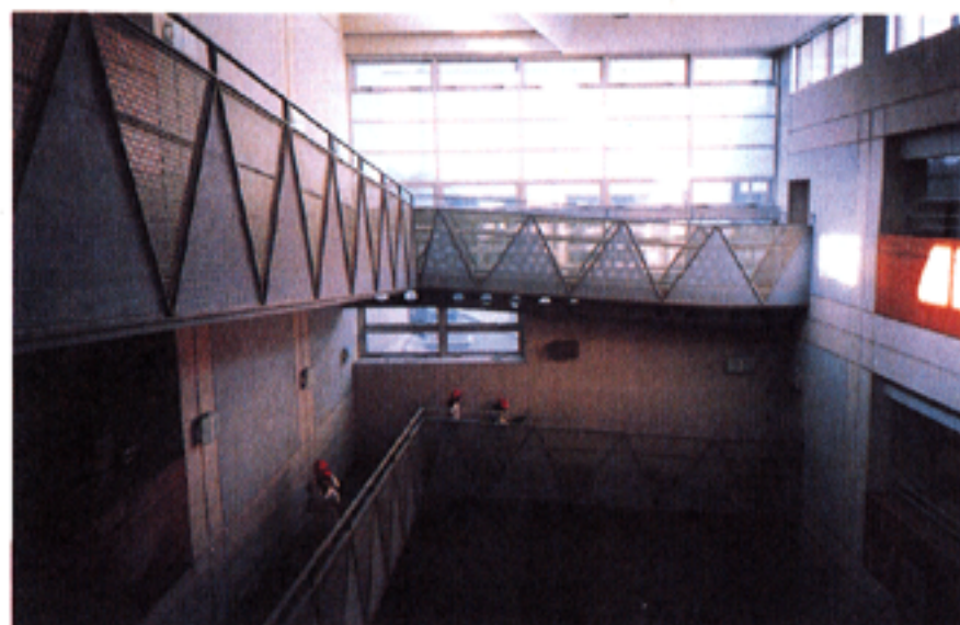
◀校舎内の各階に通じるスロープ
