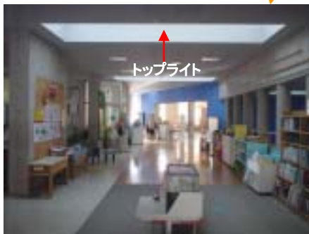
(2階中学年棟オープンスペース) オープンスペースは天井を低く抑え、トップライトを設置している。
