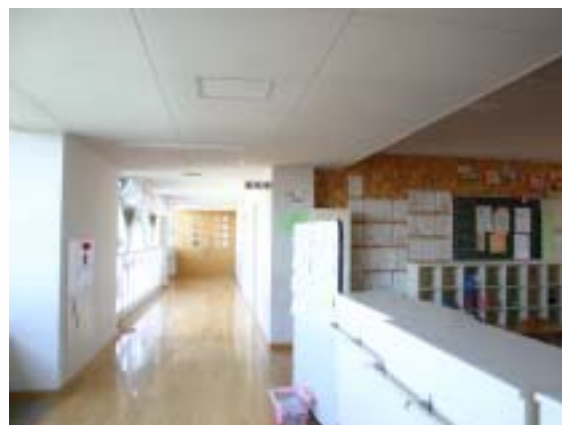
廊下部分の天井を下げ、天井内に空調設備を設置。
