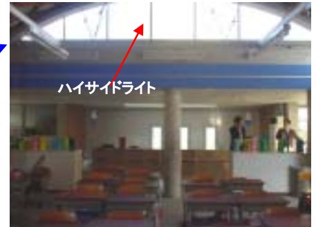
(2階高学年棟ワークスペース) 低学年棟同様、格子ボールドの天井となっている。
