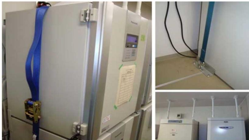
荷締めベルトと底部ブラケットによるインキュベーターの固定
