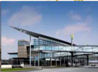
ボルグ・エル・アラブ国際空港
