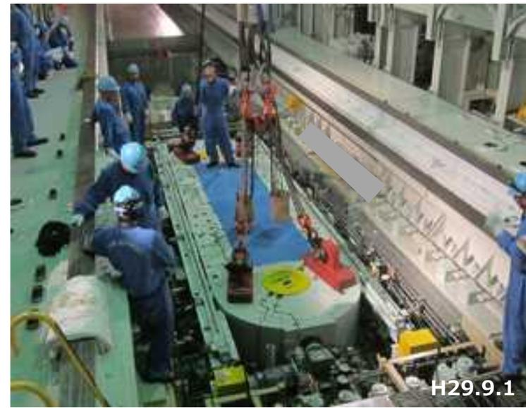
・床ドアバルブ (6連式) 取外し作業状況
