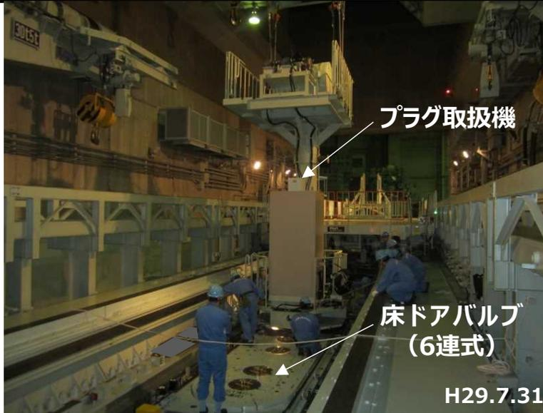
・床ドアバルブ (6連式) へのシールプラグ挿入作業状況 (プラグ取扱機据付作業)
