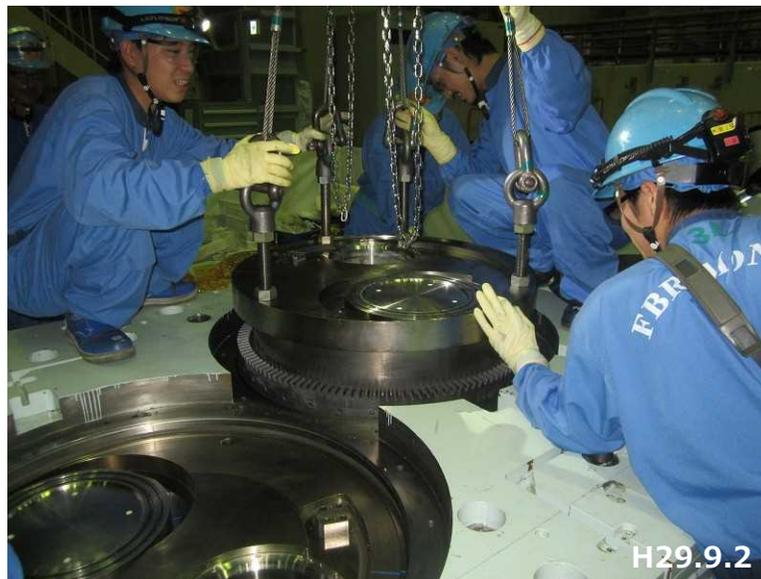
・床ドアバルブ (6連式) 分解作業状況 (弁体取外し)
