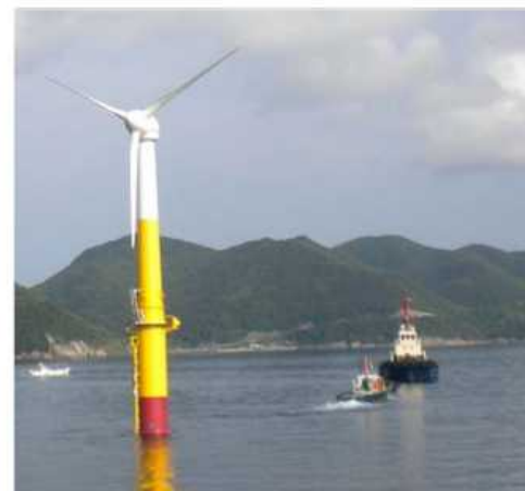
H24年6月に実証海域に設置した小規模試験機
