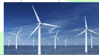
洋上風力発電施設
