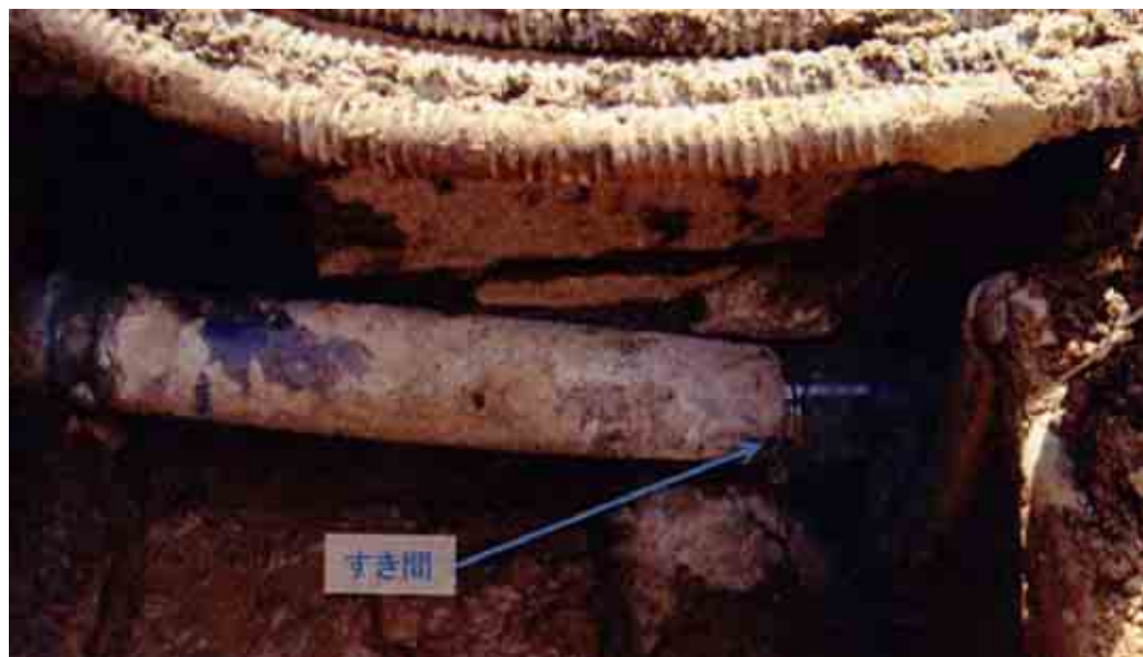
図1 配管のすき間の状況
