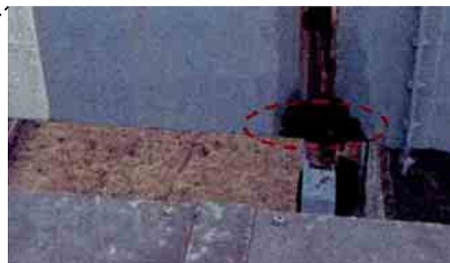
図4 腐食孔(約1cm幅×約2cm)
