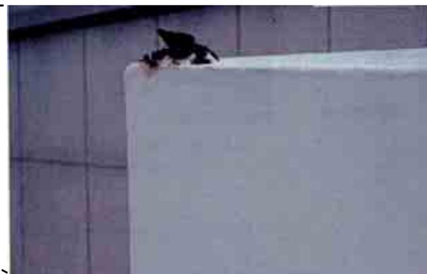
図2 腐食孔(約5cm)
