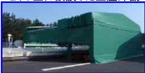
ピット上に仮設した上屋外観
