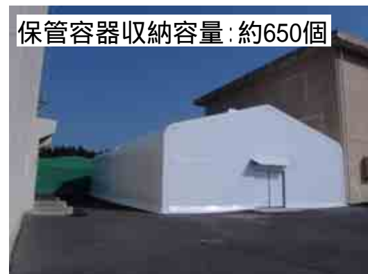
【保管容器の保管用テント倉庫】
