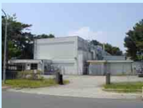
解体前の状況
