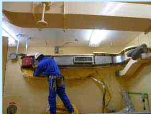
燃料作業室 給気ダクト撤去作業
