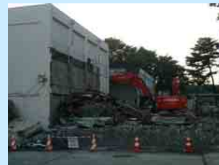
建屋(地上部)の解体
