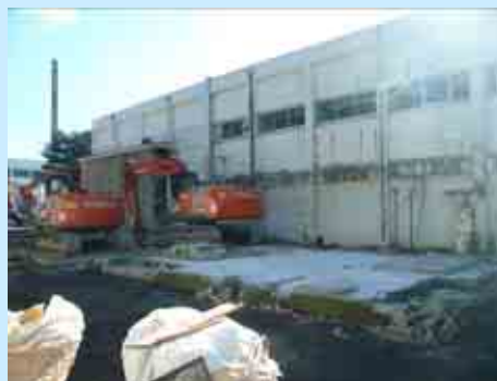
気体廃棄施設室の解体
