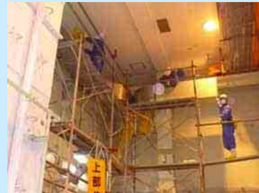
炉室 給気ダクト解体撤去
