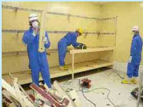
燃料貯蔵室 バードケージ棚の解体撤去
