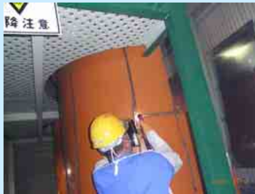
放射性廃液貯蔵室 廃液貯槽解体(胴部)
