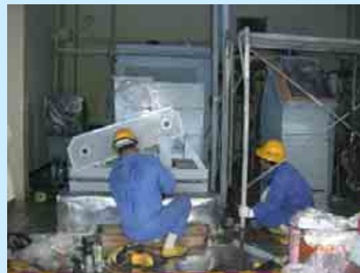
気体廃棄施設室 排風機の撤去
