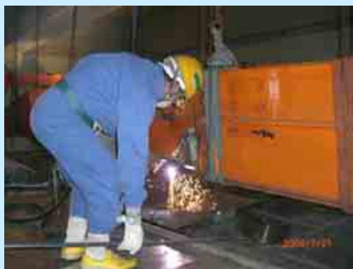
炉室 炉室クレーン解体撤去
