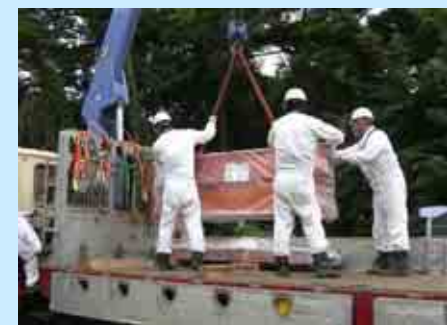
クレーン解体物の搬出
