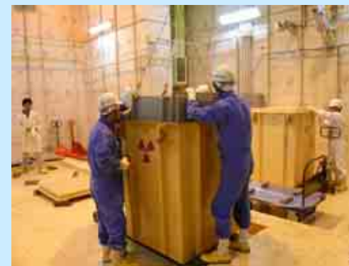
輸送容器への内容器積み込み
