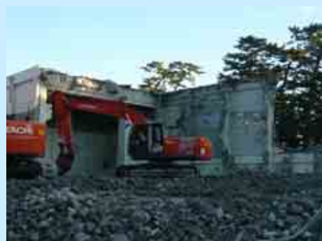
炉室・放射線遮へい体の解体
