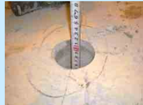
炉室床の試料採取後の状況
