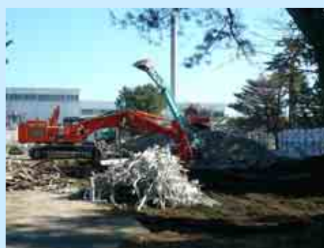
基礎部の撤去
