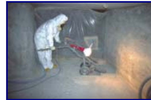
スキャブラーによる床面の除染
