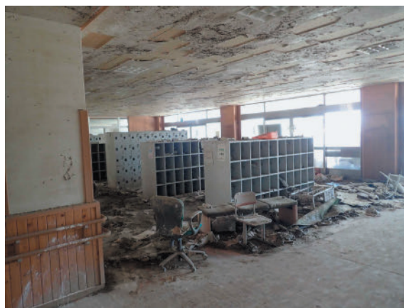
被災した学校施設（土砂流入による昇降口の被害）
