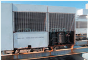
空調機の内部劣化
