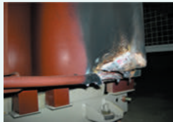
変圧器の発火による損傷
