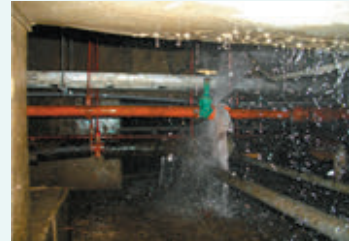
配管からの漏水
