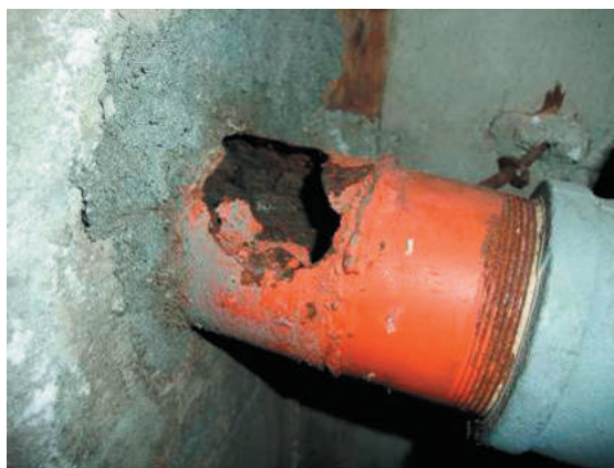
劣化による配管破損
