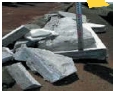
老朽化によりモルタルが落下
