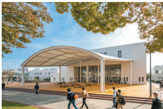
老朽化した図書館の改修
