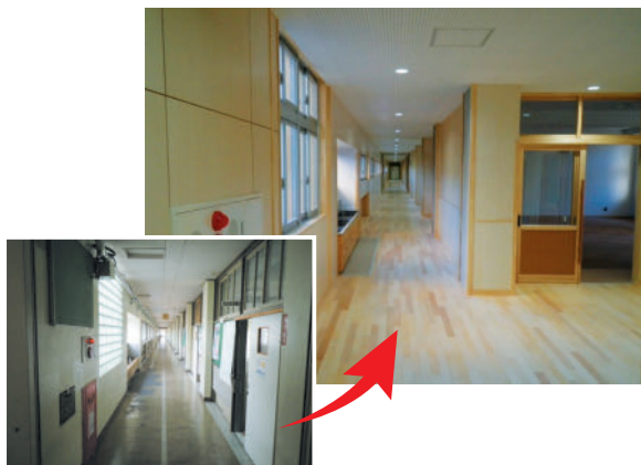
廊下の壁を一部撤去して多目的スペースを整備
