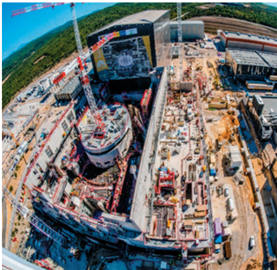
ITER (国際熱核融合実験炉) の建設状況 (2018年10月) (仏サン=ポール=レ=デュランス市カダラッシュ) ©ITER Organization
