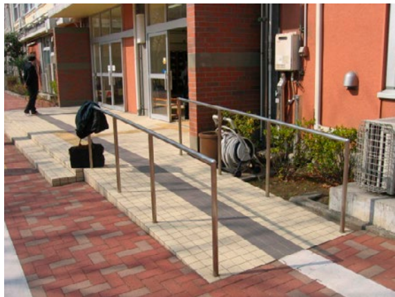
校舎出入口のスロープ（東京都世田谷区立三宿中学校） 「学校施設のバリアフリー化整備計画策定に関する実践事例集」より
