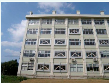
学校施設の耐震化対策 (新潟県立安塚高等学校「公立学備に関する防災対策事業活用事例集」より)
