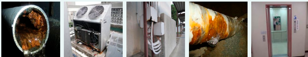
図表 2-12-8 ライフラインの老朽化（断水、空調停止、停電、ガス停止、エレベーター停止）
