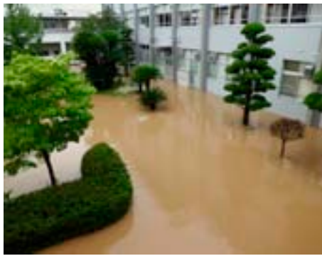
平成24年7月九州北部豪雨で被災した学校施設（浸水）
