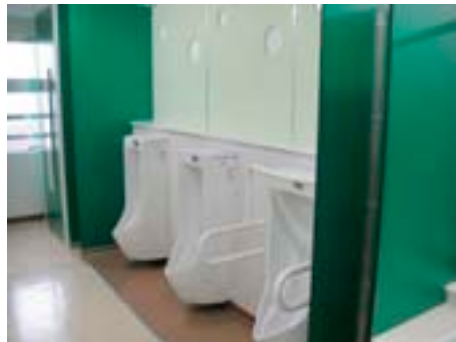
改修後のトイレ（神奈川県川崎市立有馬小学校）
