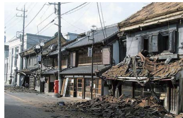
被災した重要伝統的建造物群保存地区(千葉県香取市)
