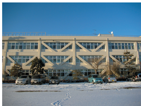
耐震補強を実施した学校施設
