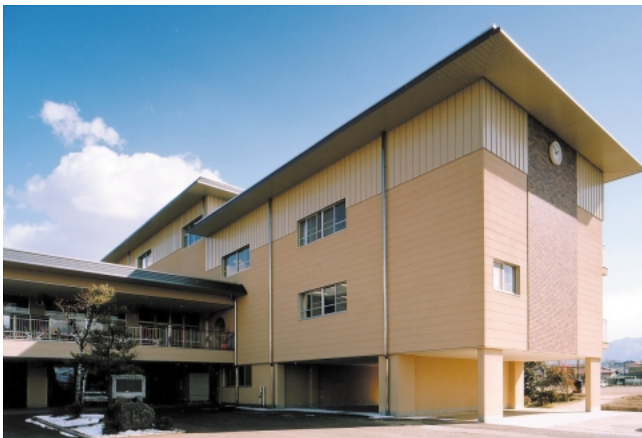
外観北西面（改修後）
