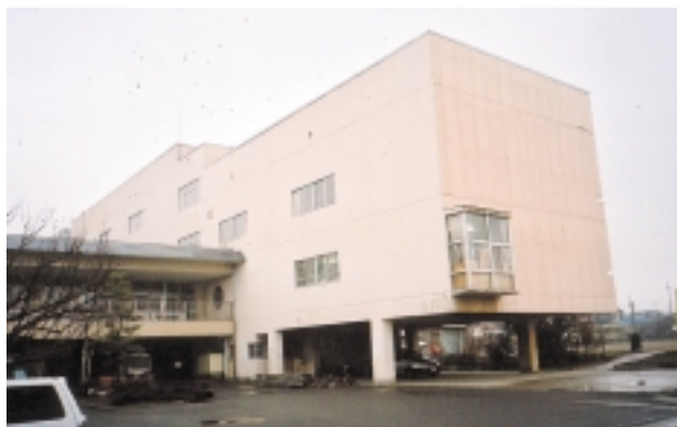
外観北西面（改修前）
