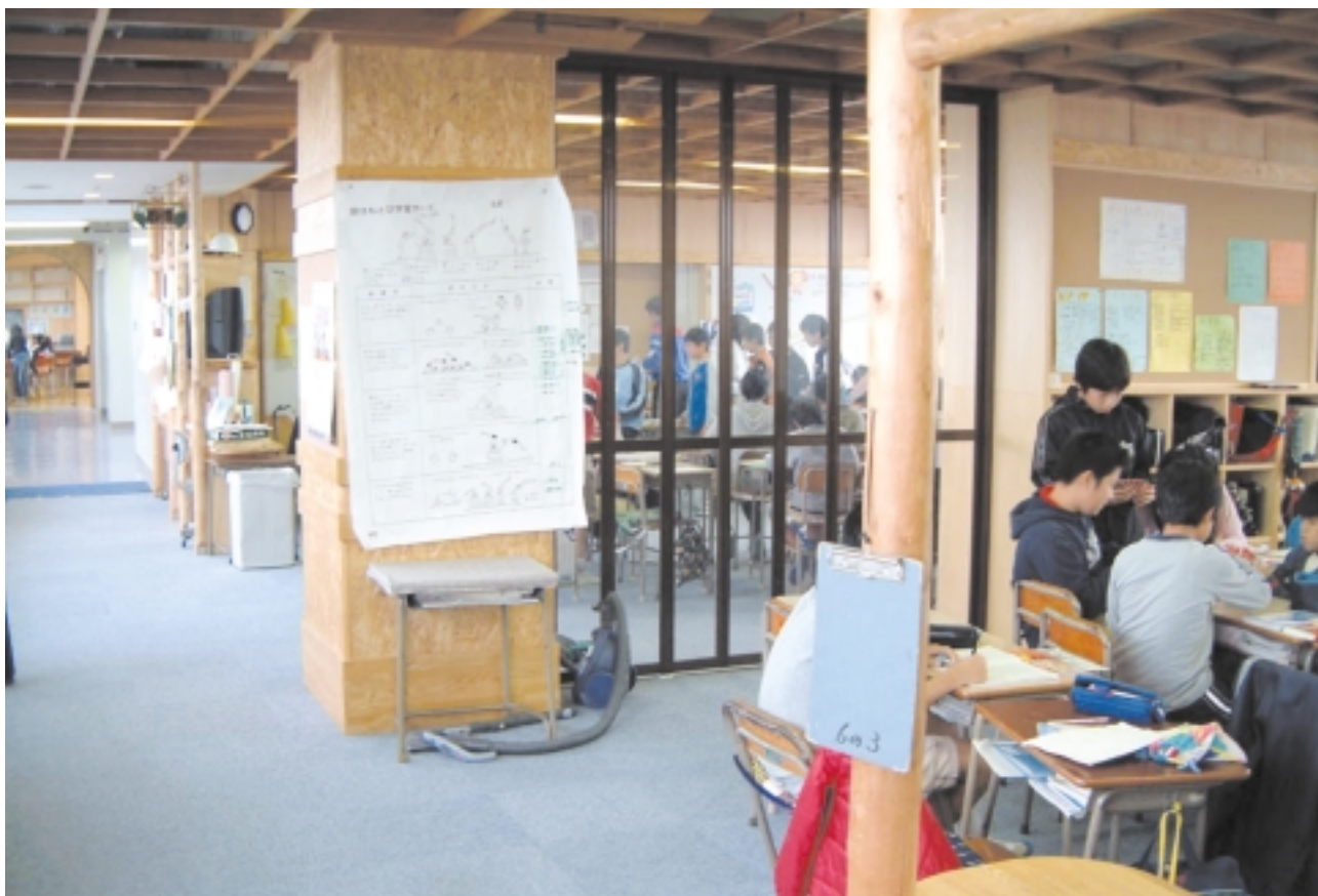
2教室の境は透明アクリルの折れ戸
