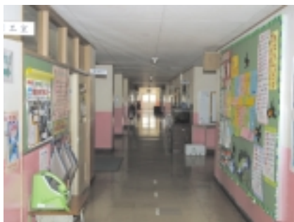
1階廊下（改修前）
