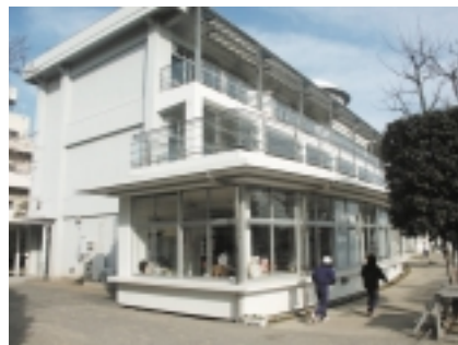
校舎の補強の様子（1階は増築された職員室）
