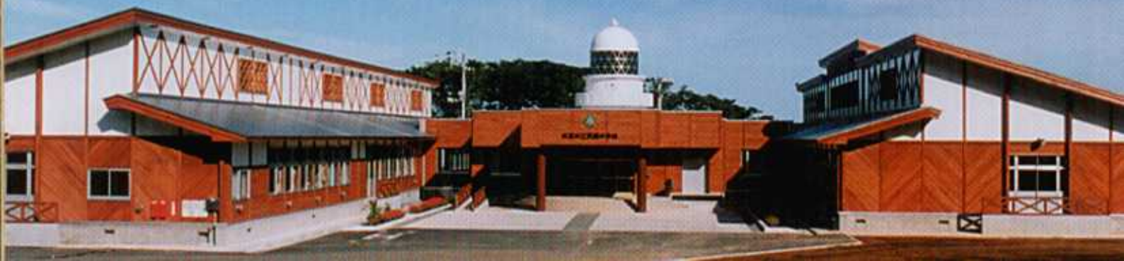
東通村立尻屋小学校（青森県／東通村）
