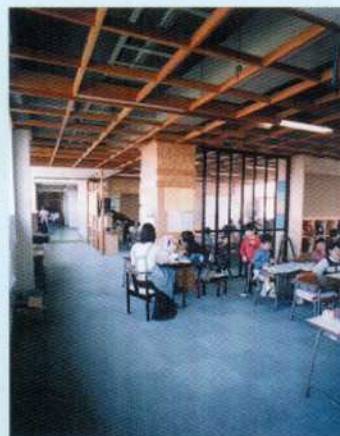
既存廊下を改修したオープンスペース
