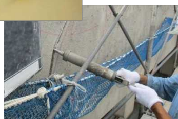
外壁補修工事
