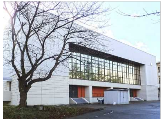
屋内運動場外観（改修後） カバー工法
