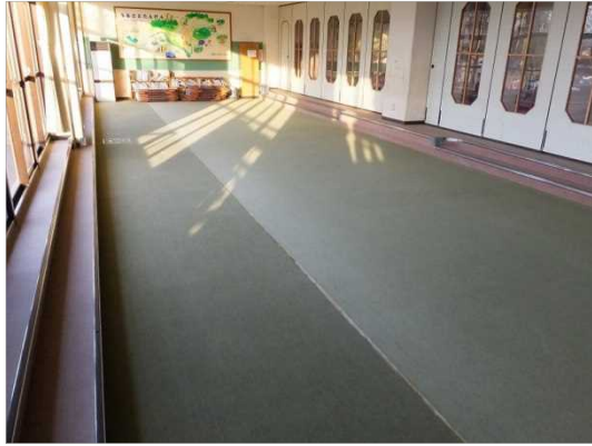
ワークルーム（改修前）
