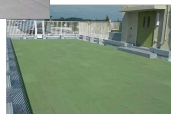
保護塗料施工(上)／アスファルト成型板張付(下)
