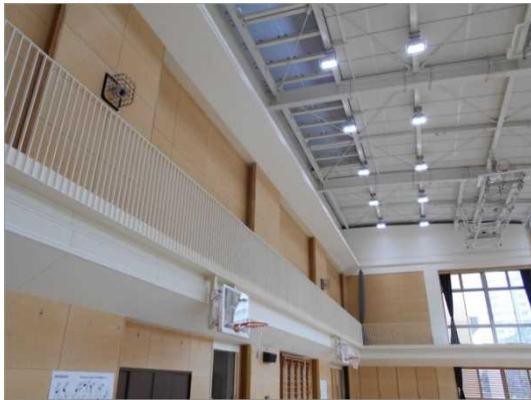
屋内運動場天井
