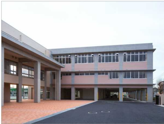
ピロティ部分
