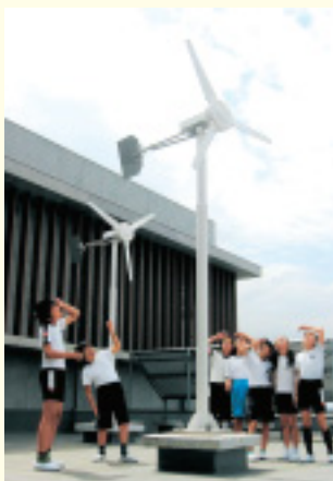
屋上に風力発電(0.3kW×3台)を設置(富山県富山市立中央小学校)
