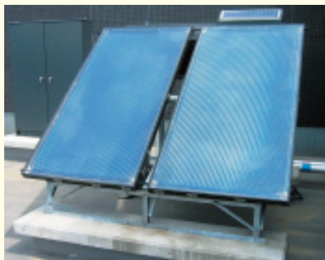
太陽熱により暖められた水をシャワー室の温水に活用 (富山県富山市立中央小学校)
