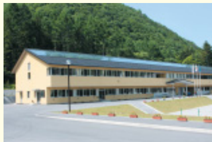
太陽熱により暖められた空気を校舎の床下に送風し、暖房に活用 (栃木県日光市立湯西川小・中学校)
