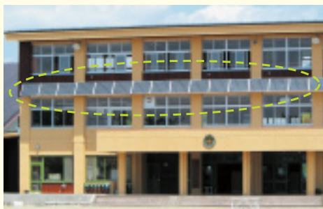
庇を兼ねた10kWの太陽光発電パネルを設置(兵庫県尼崎市立成良中学校)
