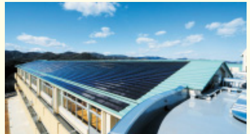
校舎屋根に40kWの太陽光発電パネルを設置(静岡県湖西市立岡崎中学校)
