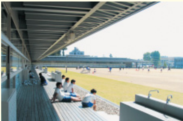
強い日差しを遮る庇(福井県大野市立有終西小学校)
