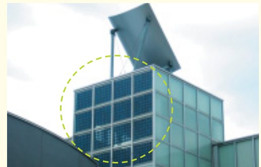
校舎壁面ガラスに1.4kWのシースルー型太陽光発電パネルを設置(富山県射水市立大門小学校)
