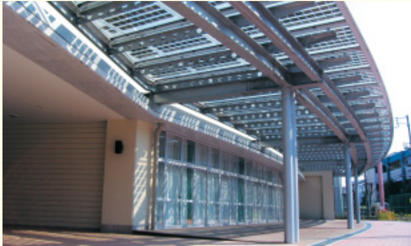
庇を兼ねた10kWの太陽光発電パネルを設置(兵庫県尼崎市立成良中学校)
