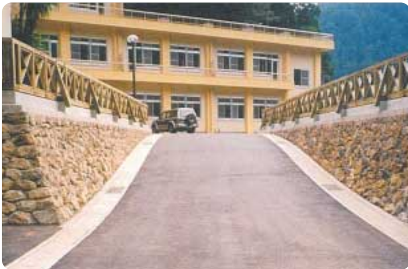
○敷地入口付近
