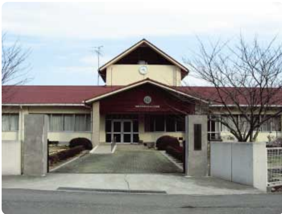
○平成6年に竣工した比較的新しい校舎の外観
