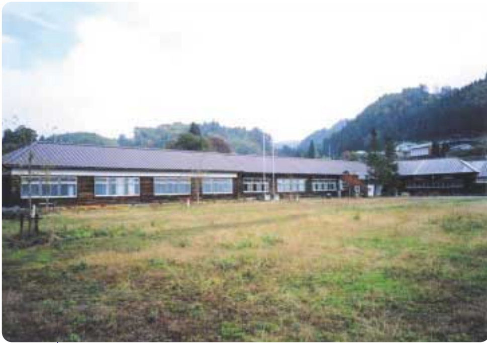
○明治から昭和初期に建てられた 木造平屋の外観
