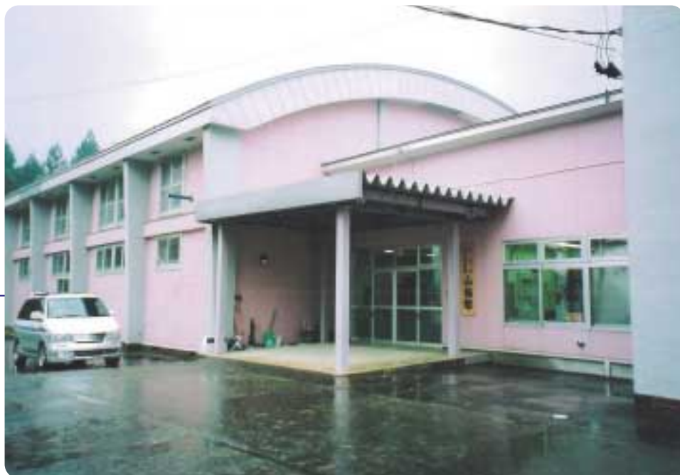
○ピンク色の建物の外観
