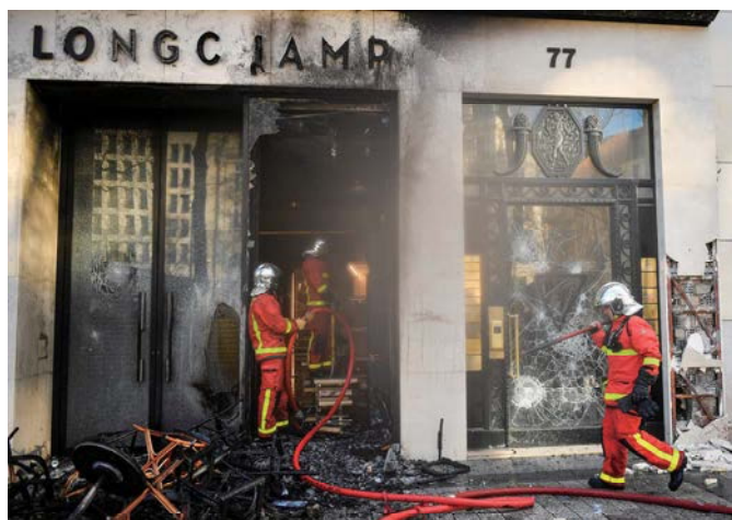
②反政府デモのなかで放火された店舗 (2019年、フランス) ディーゼル燃料税の引き上げなどに対しておこされたデモのなかで、商店への放火や略奪 りやくだつ などがおき、死傷者が発生する事態となった。
