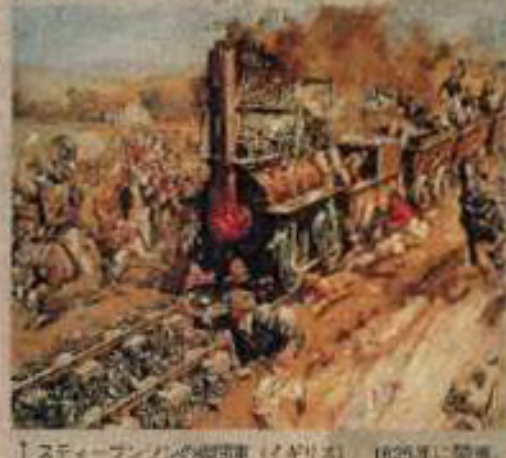
↑ スティーブソンの蒸気機関車（イギリス） 1825年に開通。
