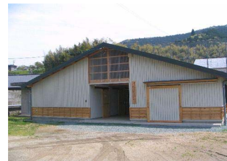
部室等の学校関連施設
