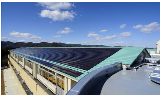
校舎屋根に太陽光パネルを設置
