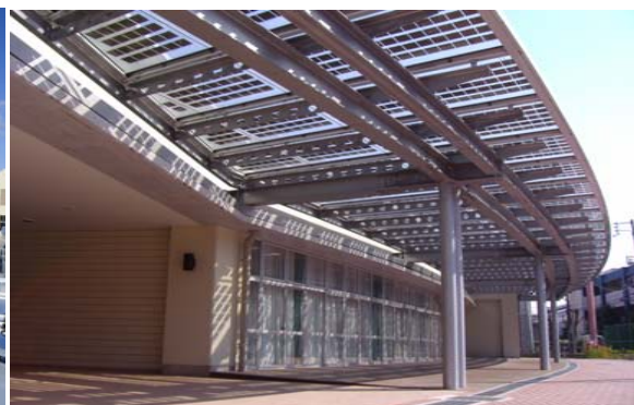
庇を兼ねた太陽光パネルを設置
