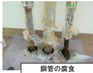
外階段の劣化・損傷
