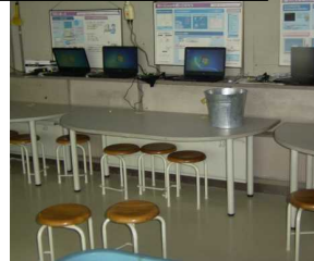
雨漏りによりパソコンの一部が破損
