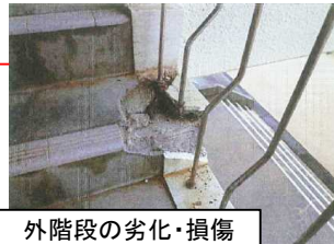
外階段の劣化・損傷
