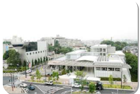
(例：東京工業大学 蔵前会館(手前施設))
