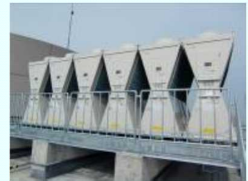
更新された空調屋外機
