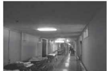
天井が低く薄暗い廊下
