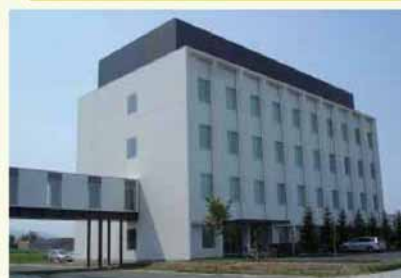
北海道大学 / 創薬基盤技術研究棟
