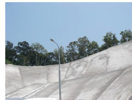
土塊撤去＋コンクリート吹付け
