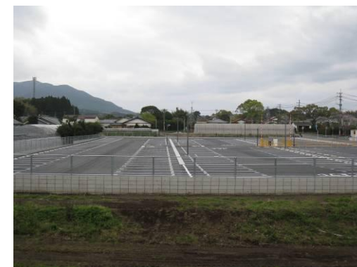
透水性アスファルト舗装で整備された駐車場
