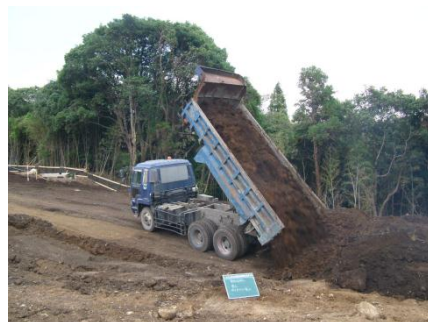
(発生土構内運搬)
