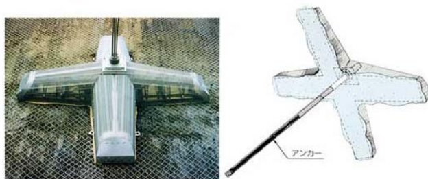
法枠＋アンカー工法
