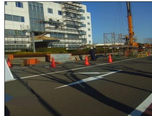
大組大払工法(地上で組払い)
