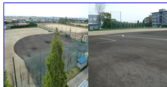
既設表層（良質土）を再利用し黒土混合土の補充する工法
