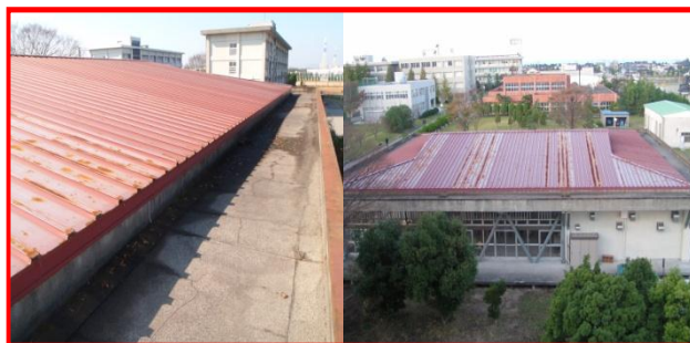
屋根材の撤去
