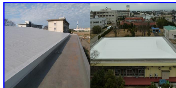
屋根材を残し、かぶせ工法
