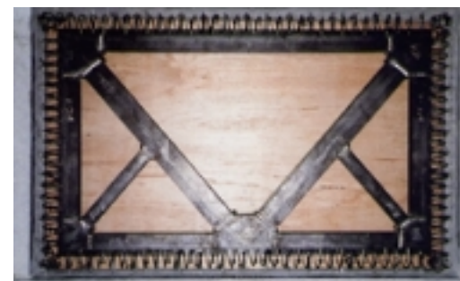
ハイブリッド耐震ブレース（施工写真）
