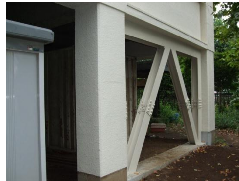
外側ブレース
