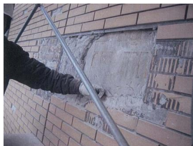
外壁タイル撤去 及び張替工法
