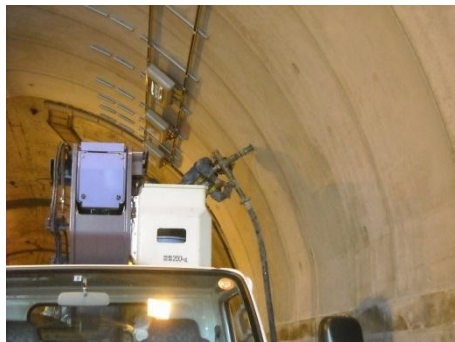
従来の削孔 径32mm
