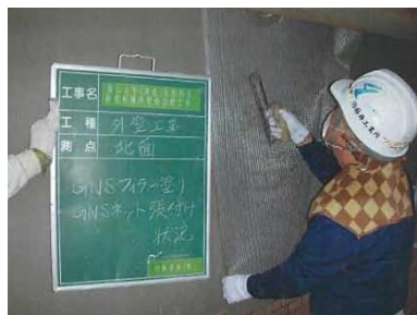
ピンネット補強＋下地調整材塗り＋タイル調吹付け工法
