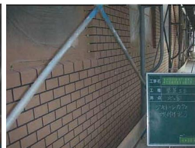
ピンネット補強＋下地調整材塗り＋タイル調吹付け工法
