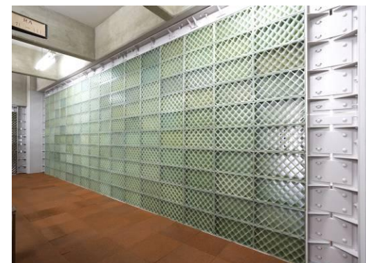
～ FRPブロック施工写真 ～
