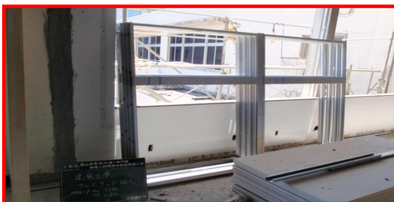
撤去(はつり)工法
