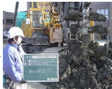
←深層混合処理工法
