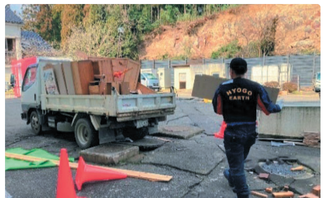
被災地のがれき処理を行う様子
