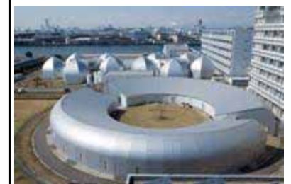
核磁気共鳴装置 (NMR) 施設
