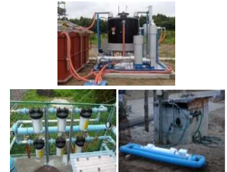
富岡道路工事現場(上)、プール(左)、井戸水(右)での安全安心確保
