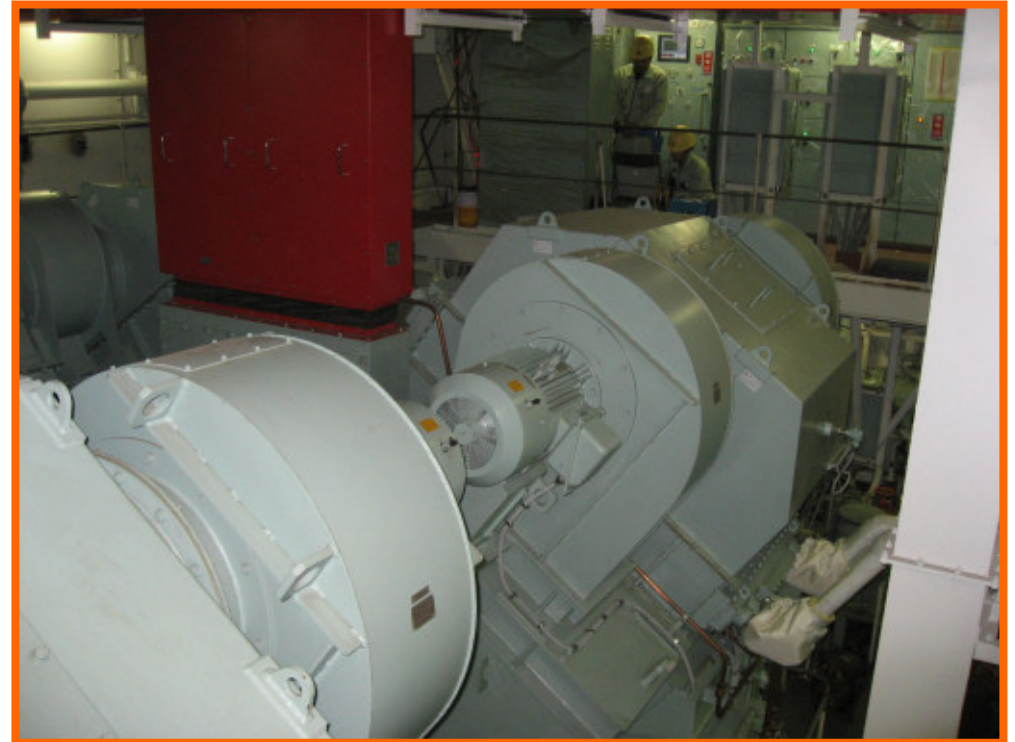
推進電動機室(11月7日)
