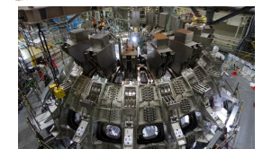
TFコイル組立てが進められているJT-60SA本体
