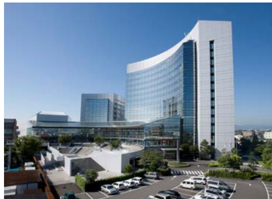
写真－2 岐阜県県民ふれあい会館
