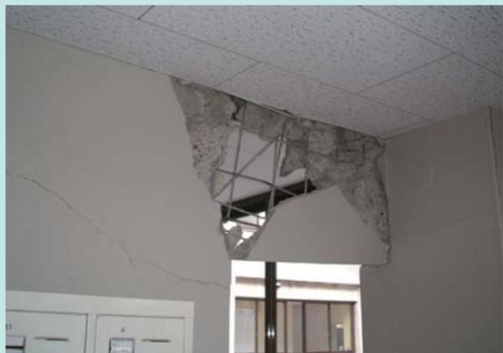
地震により亀裂が入り、剥離した内壁
