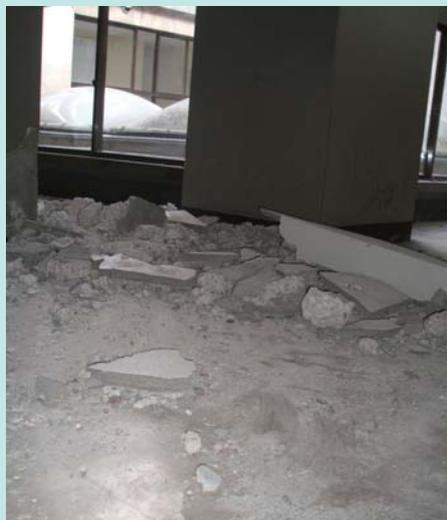
地震により、崩落した内壁
