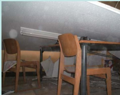
脱落した天井材の下敷きとなった机椅子
