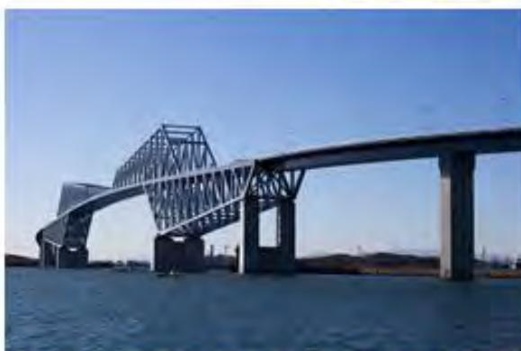
「東京ゲートブリッジ」のコンセプトは「耐用年数100年を目指す橋梁」であり、様々な最新技術が導入されている。すべり型免震支承は、鉛直力・水平力をそれぞれ負担する支承から構成され、橋梁中央部の2つの主橋脚部に2基ずつ並べて設置されている。大地震などの際、既存の免震支承で支えられる水平力の3倍に達する7,000tのトラス重量を、荷重支持板・バウファといった機能の異なる2つの支承を組み合わせる事で解決した。また、伸縮・歪みの計測センサーが橋の中に埋め込まれており、計測したデータを自動監視する事で災害時の影響をすぐに把握できるようになっている。
